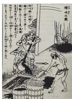
図3 江戸時代の伝統技法である“摸”の様子
