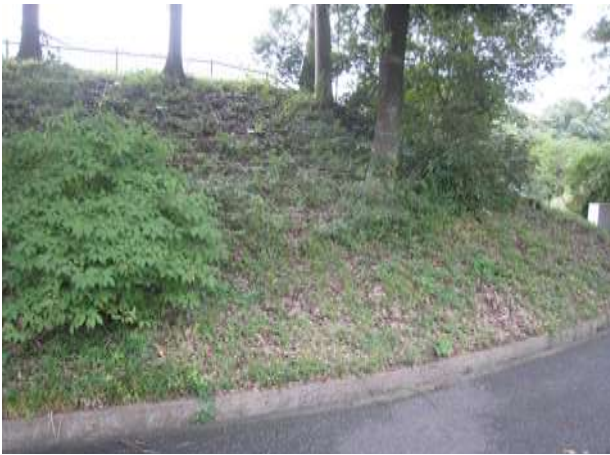
Fig. 1 水戸第一高等学校の土手
